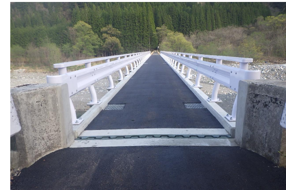
< 下部工 > 橋 脚：P4橋脚（RC橋脚）N=1基
