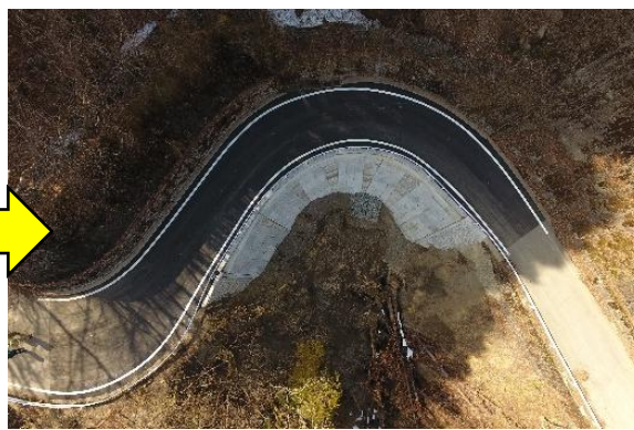
令和4年3月25日完成 復旧延長L=34m 路側工（大型ブロック）A=188㎡ 防護柵工（Gr-C-2B）L=26.1m 舗装工（5cm）A=252㎡
