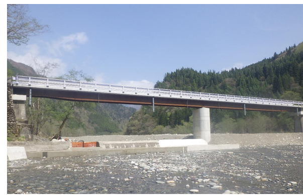
令和5年5月26日完成 復旧延長L=57.6m < 上部工 > 橋 長：L=57.63m 有効幅員：W=2.1m 橋梁形式：鋼橋（2径間連続合成版桁）
