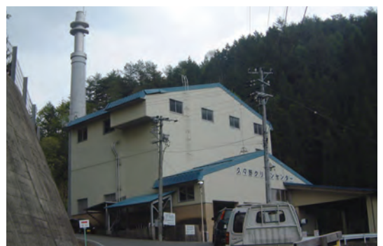
現在の久々野クリーンセンター焼却施設(久々野町久々野)
