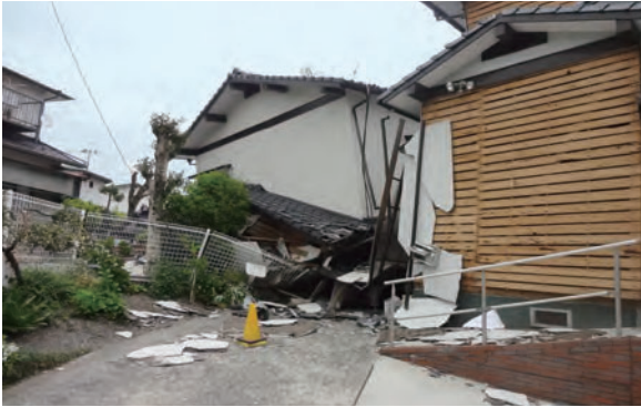
平成28年熊本地震 熊本県益城町(最大震度7)
