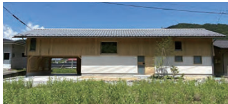
▲ 溝脇邸 (建築物の部)
