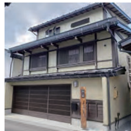
▲ I邸 (建築物の部)
