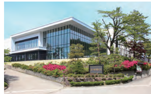
新たに今春完成した「実習センター」
