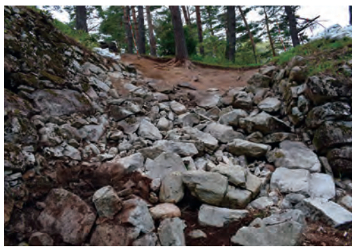
崩れた石垣①
