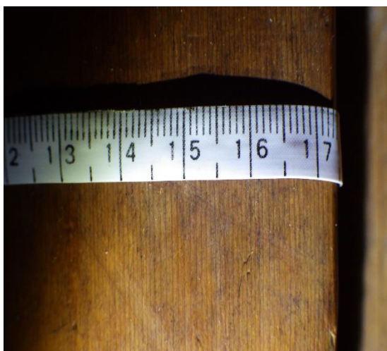
写真 12 No.1 の間仕切り柱
