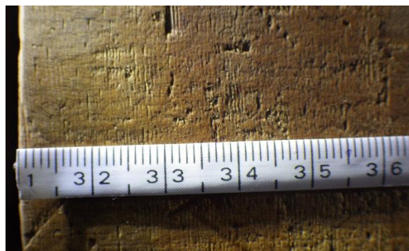
写真 15 同床板 1 の年輪画像 (左端に辺材)
