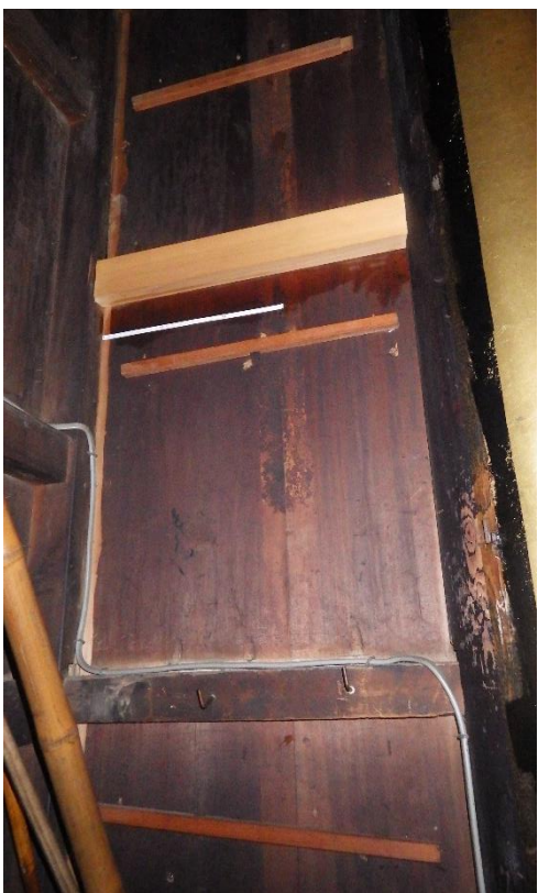
写真6 仏殿背面縦板壁
