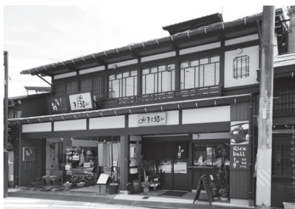
建築物の部奨励賞 きよ結び、青
