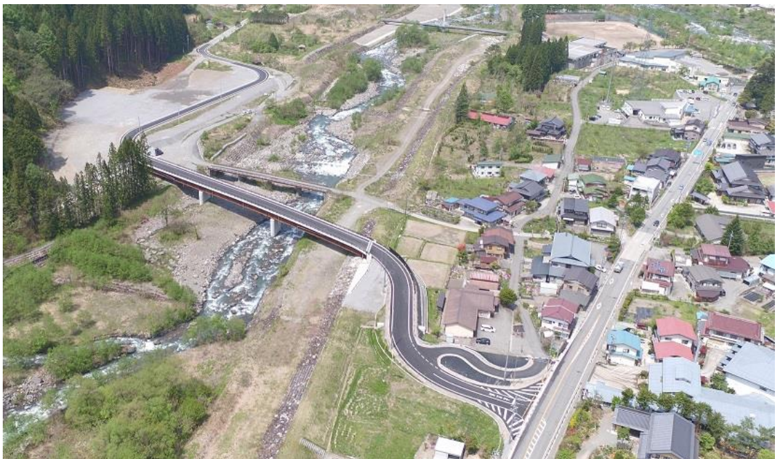
橋りょう整備事業（村上橋）
