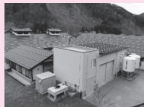
しぶきの湯(バイオマス発電所)
