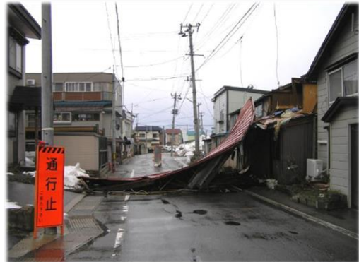
強風による屋根等の飛散
