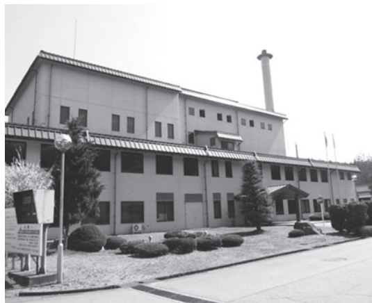
資源リサイクルセンター焼却施設(昭和61年築)
