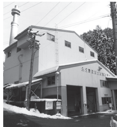
久々野クリーンセンター焼却施設(平成2年築)
