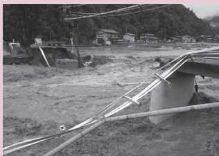
崩壊した清見町の河渡橋
