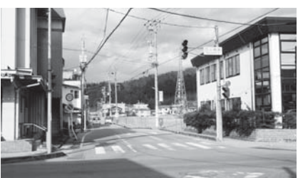
改良工事予定の千島松本線
