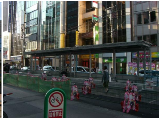
停留所の工事風景
