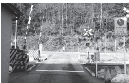
広瀬踏切道(国府町)
