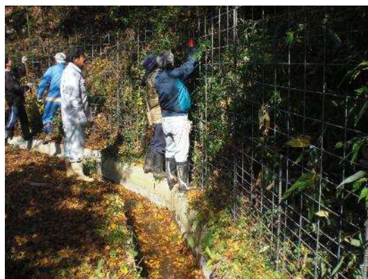
鳥獣被害防止柵設置（作業風景）
