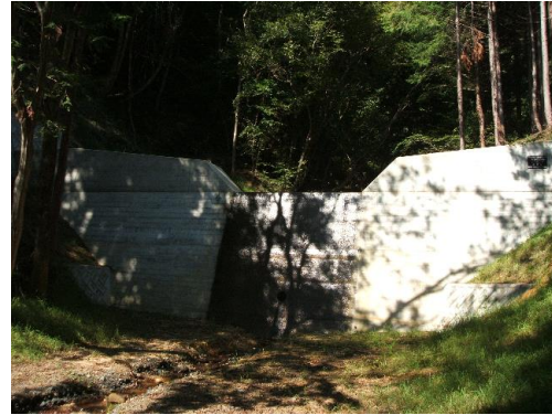
治山工事施工後
