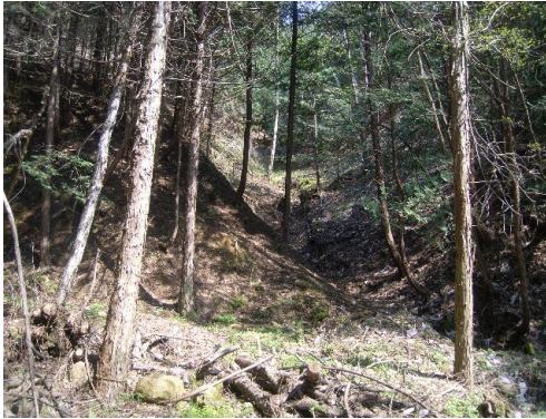
治山工事施工前
