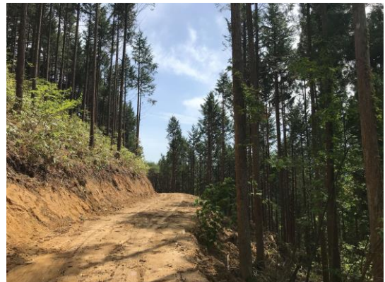
作業道の開設状況
