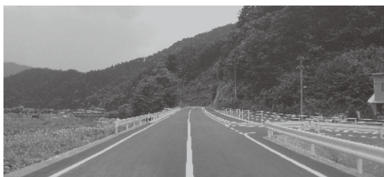
6月完成の市道八日町下林線改良工事
