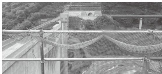
H24年度完成に向け工事が進む丹生川ダム
