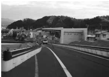
工事が進む中部縦貫道（冬頭町方面へ）
