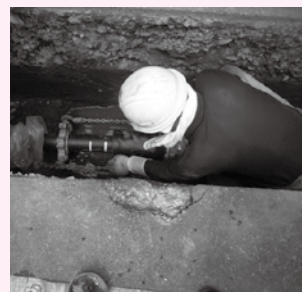
耐震管の布設替え工事(さいたま市)
