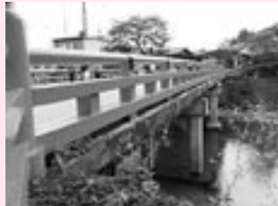
補強が必要な橋りょう
