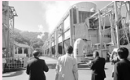
地熱発電を行っている八丁原発電所
