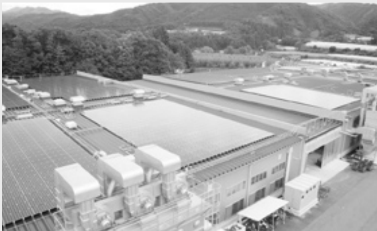
飛騨産業株式会社の太陽光パネル8,500㎡の本社工場屋上に、幅1.6m×0.9mのソーラー発電パネル2136枚を設置し、年間415,300kwを発電
