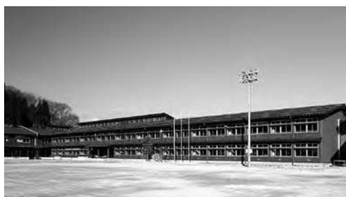
3月に完成した東小学校校舎
