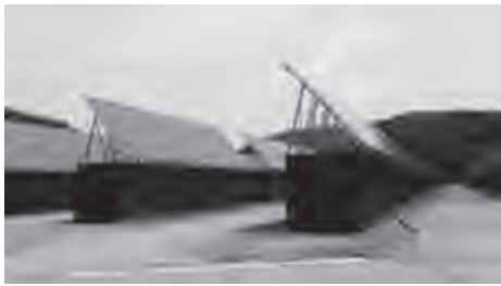
積雪対策のためコンテナ上に設置
