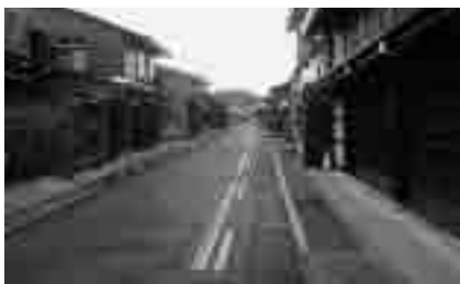
今春に完了する大新町地内の無電柱化事業
