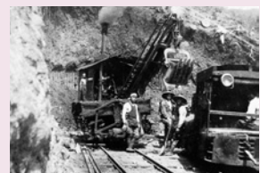
工事中の宮トンネル
