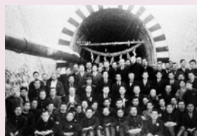
宮トンネル完成
