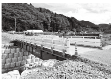
国土交通省の支援を受け宮前橋仮設橋が完成(清見町巣野俣)
