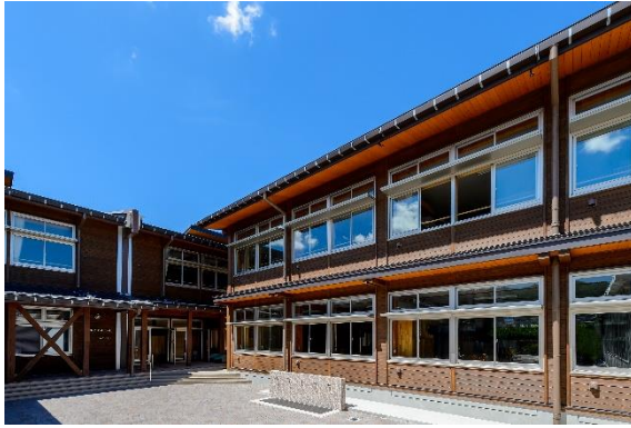
公共施設の木造化（高山市立東小学校）
