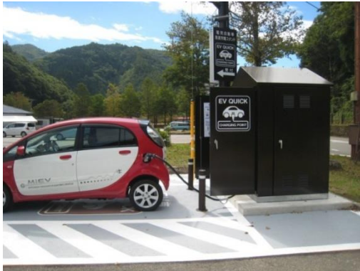
急速充電器（道の駅パスカル清見）
