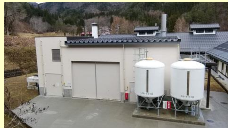
（しぶきの湯 木質バイオマス発電所）
