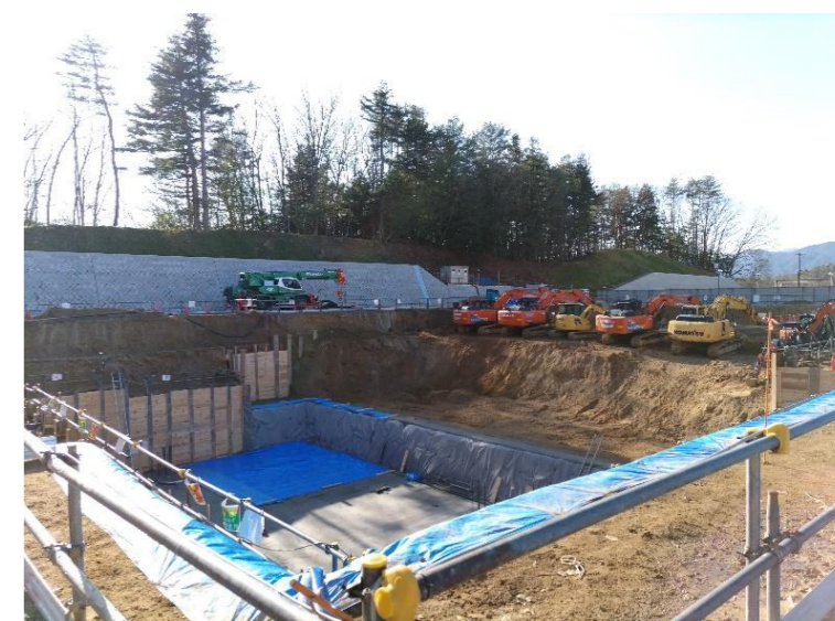
・ごみピットコンクリート打設状況(1月末)(③方向)
