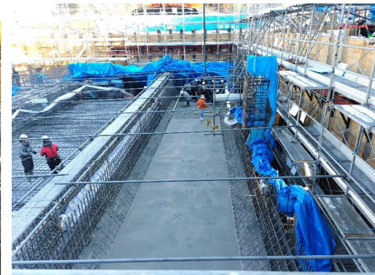
・ごみピットコンクリート打設状況(1月末)(③方向)
