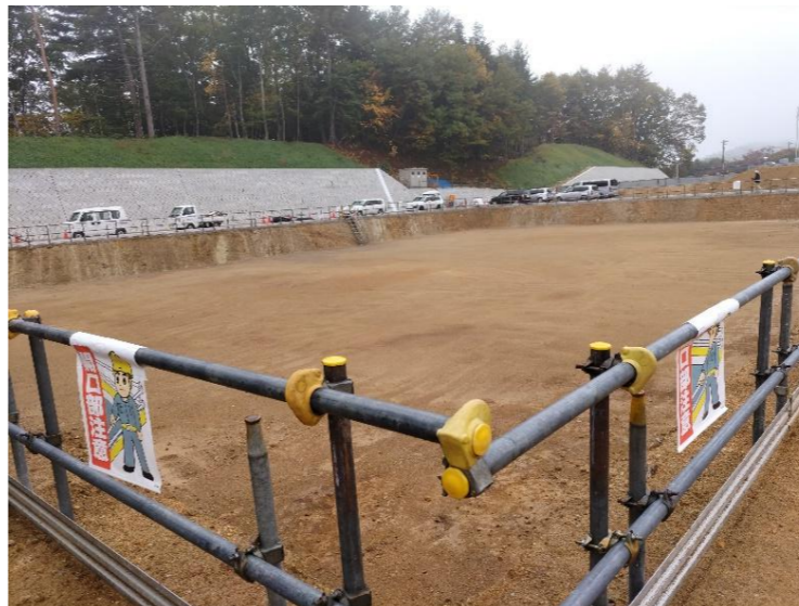
・作業前状況(令和5年10月)(①方向)
