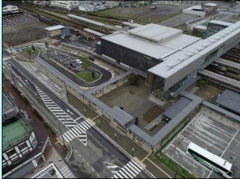
高山駅周辺整備の完了状況
