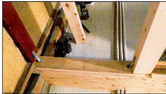
補強金物取付、柱新設、土台構造用合板貼付
