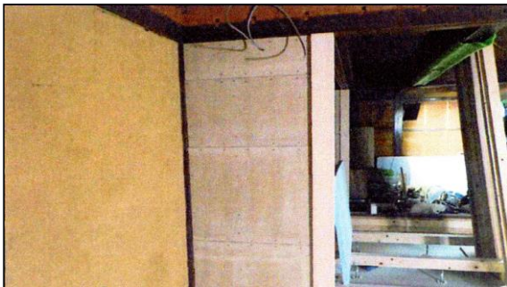
荒壁パネル設置、柱新設
