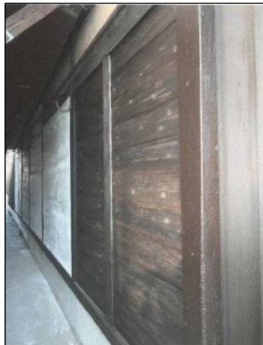
耐力壁の設置による耐震補強
