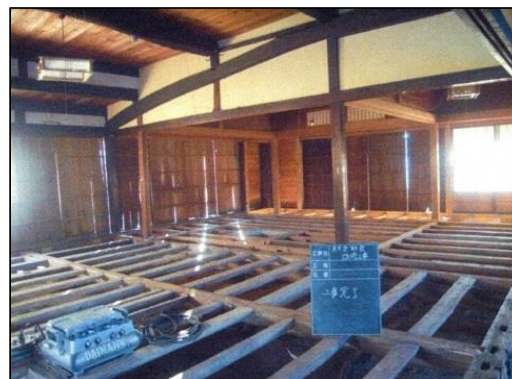
垂れ壁の補修による耐震補強
