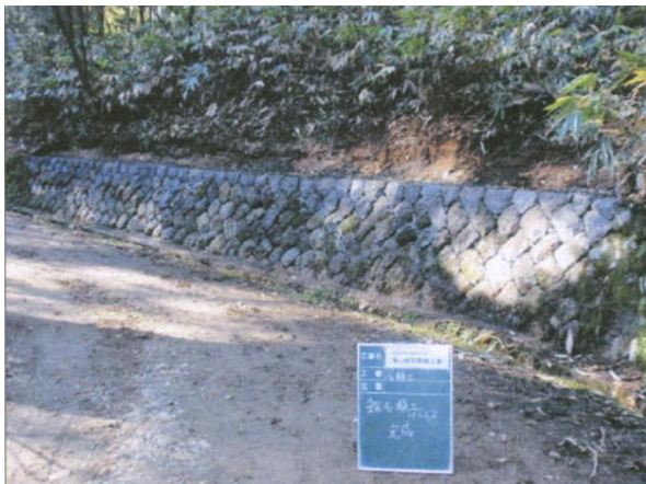
遊歩道保護のための石積み整備
