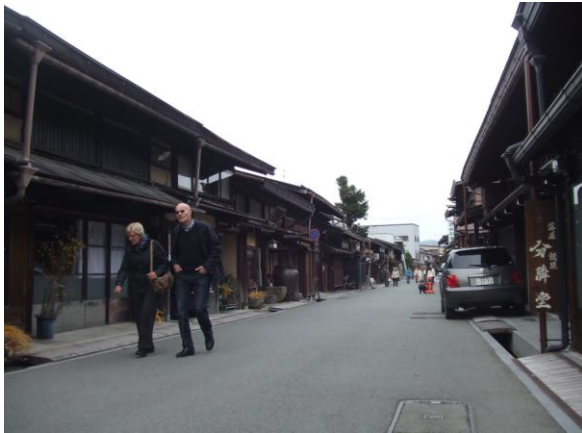
伝建地区における無電柱化事業
