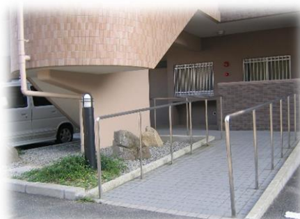
駐車場から住宅への出入りがしやすいようスロープを設置
