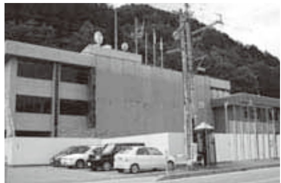
耐震化と併せて複合化の工事が進む清見支所
