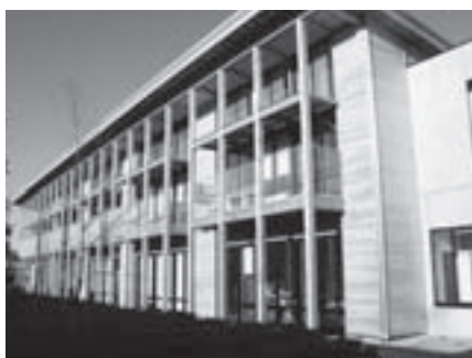
改築が終了した中山中の校舎。現在は体育館の改築を進めています。
