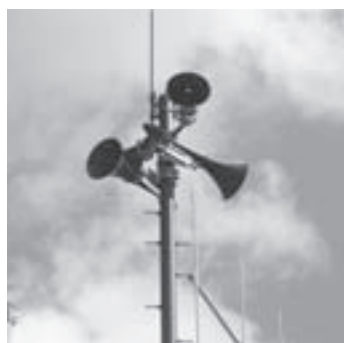
整備された防災行政無線の屋外拡声器。無線電話も装備されています。
