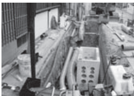
伝建地区で進む無電柱化の工事
