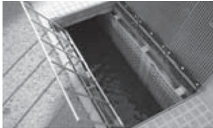
流雪溝。スクリーンにより水の流れが確保されます。排雪後は安全のためグレーチングを閉めてください
