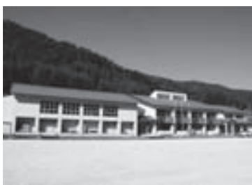
旧日和田小学校の校舎
