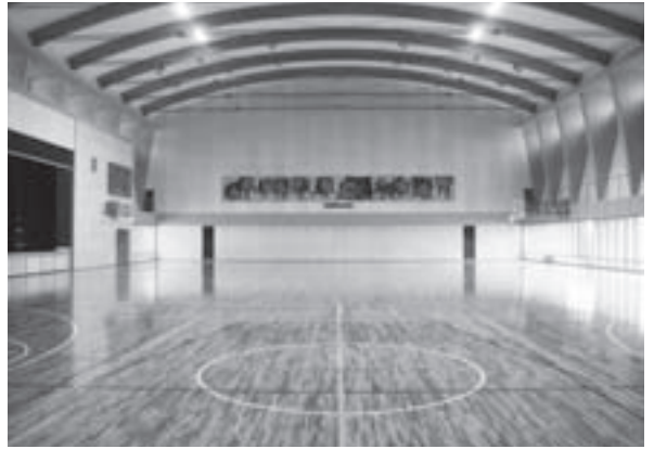
工事が完了した中山中学校屋内運動場
