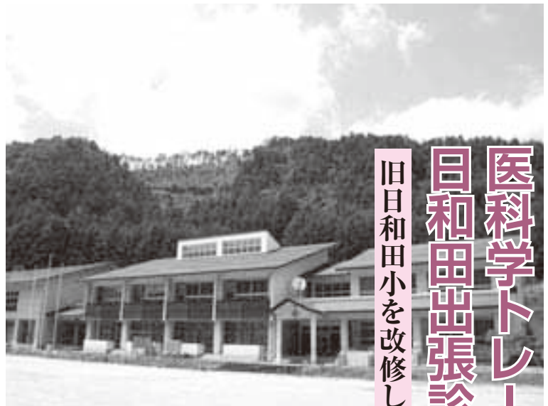
旧目和田小を改修し、高地トレーニングセンターとしてスタートする「飛騨高山御嶽トレーニングセンター」
