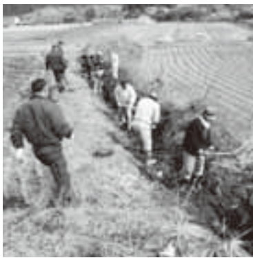
側溝の土砂上げ作業の様子
