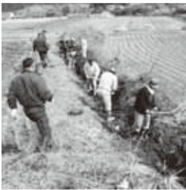
側溝の土砂上げ作業の様子
