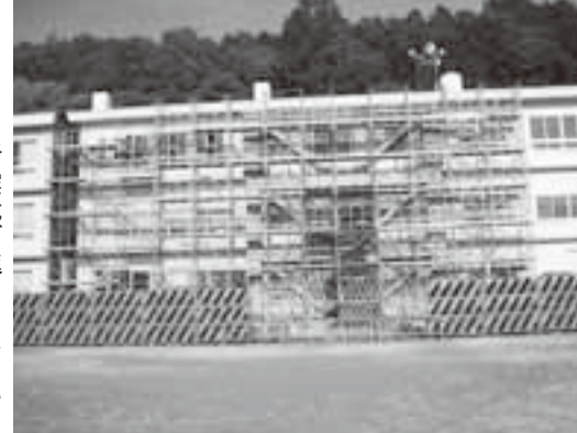
耐震化が進められている三枝小学校舎
