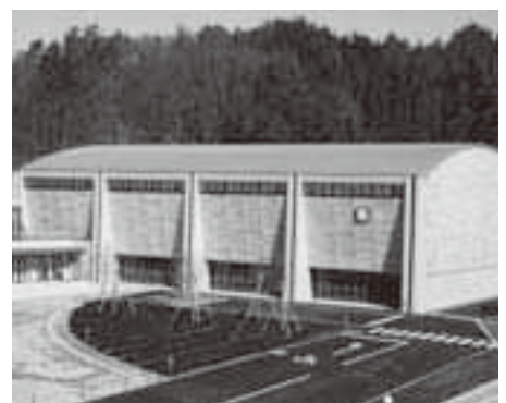
改築工事が終了した中山中体育館
