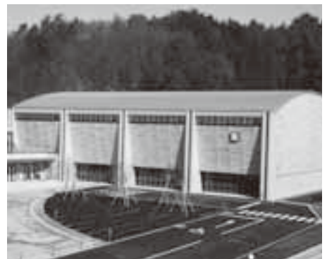
改築工事が終了した中山中体育館
