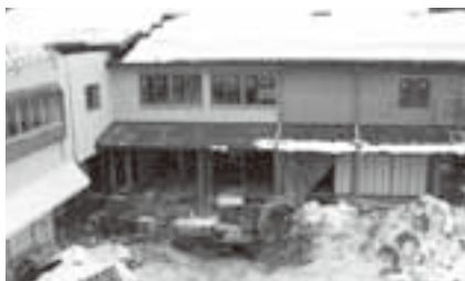
改築工事が進む国府小学校
