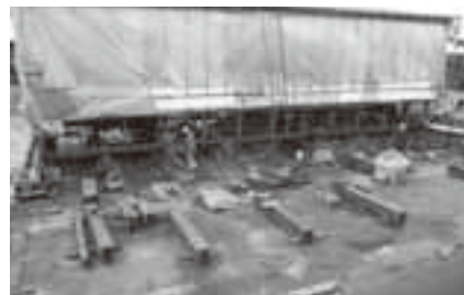
城下町高山の交流拠点として整備が進む旧矢嶋邸(曳き家作業の様子)
