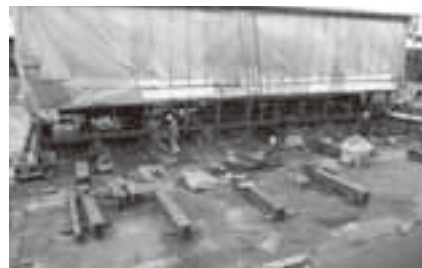
城下町高山の交流拠点として整備が進む旧矢嶋邸(曳き家作業の様子)
