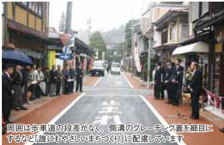
周囲は歩車道の段差がなく、側溝のグレーチング蓋を細目にするなど「誰にもやさしいまちづくり」に配慮しています
